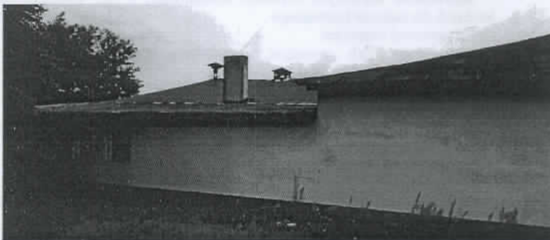
Fot. Elewacja tylna
